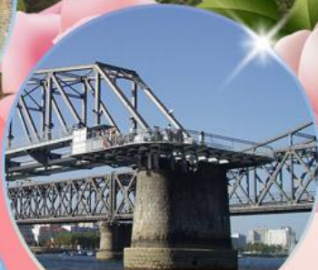
สะพานขาดตานตง
